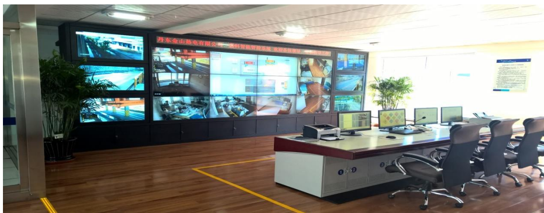
图9 华电丹东金山热燃料管控室现场图
