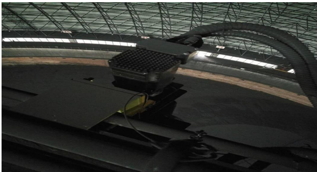
图10 激光扫描仪现场安装图
