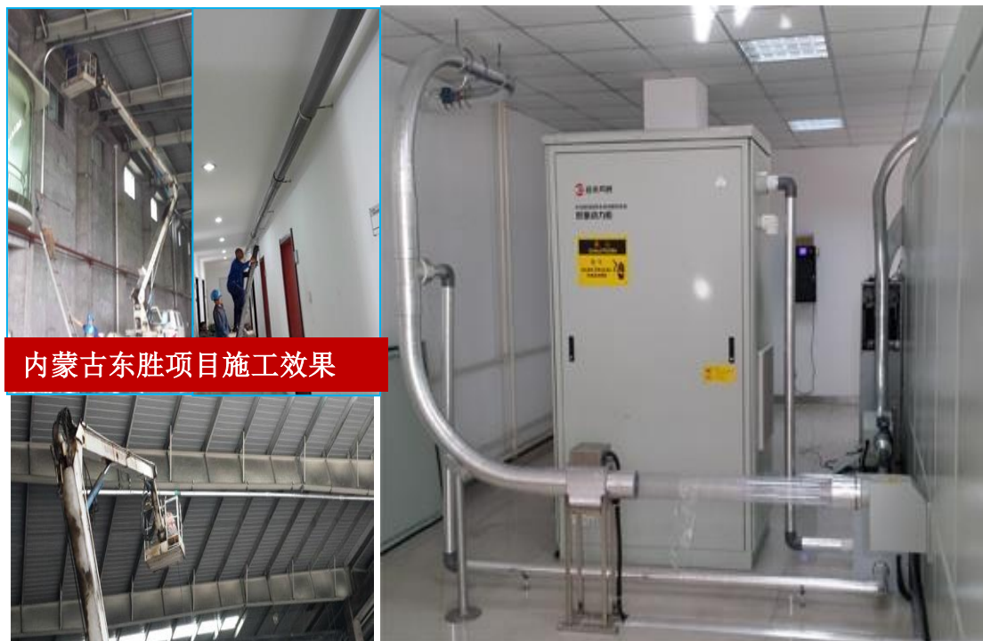
图7 气动传输管道与存查样柜连接部分和双驱动力柜安装及现场图
