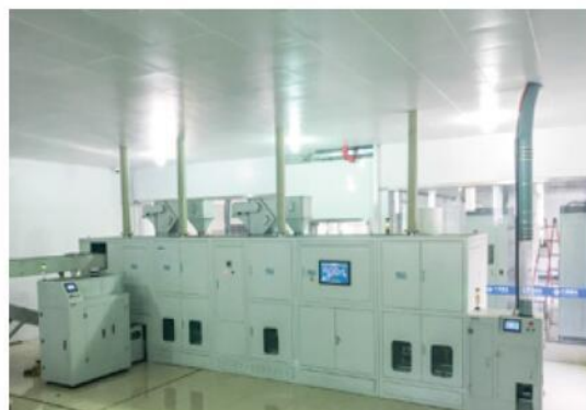
• 聊城电厂项目现场 •
