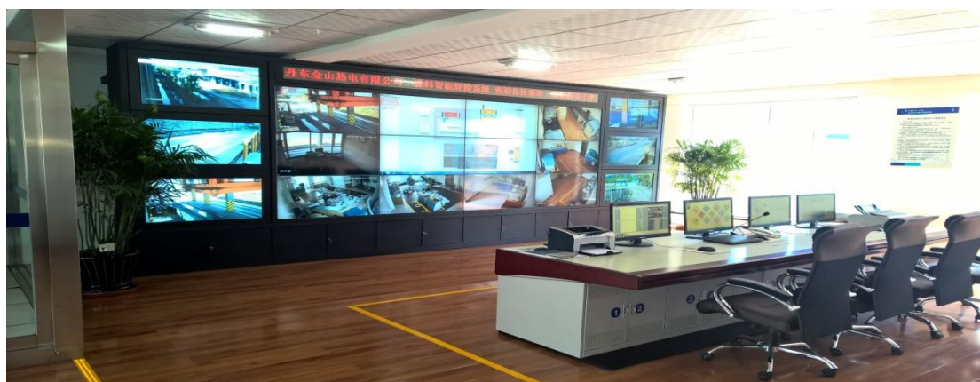
图21 华电丹东金山热燃料管控室现场图
