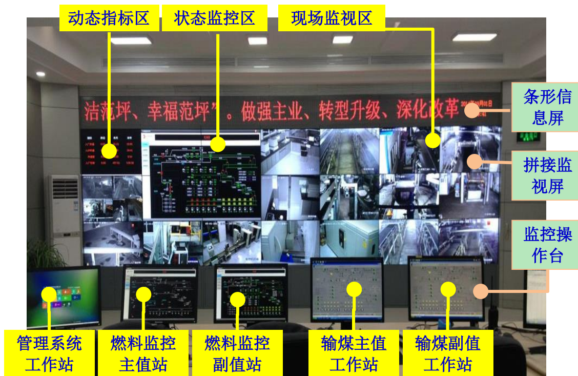
图4 控制室现场图
